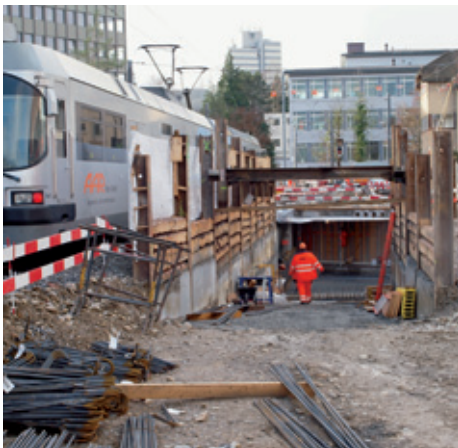
Bauarbeiten der neuen Rampe
