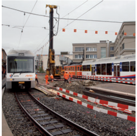
Ramarbeiten als Vorbereitung für die neue Rampe
